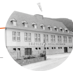
Neuer Bauabschnitt – Brunnenhaus.
